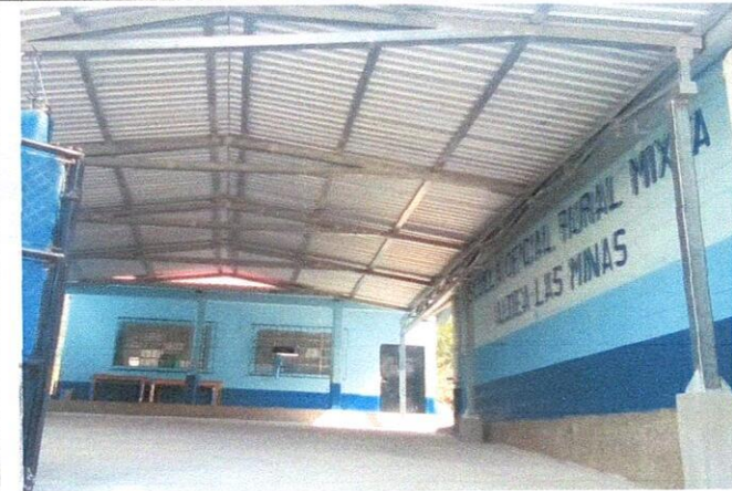
Foto 3: Mejoramiento de Estructura Metalica.
