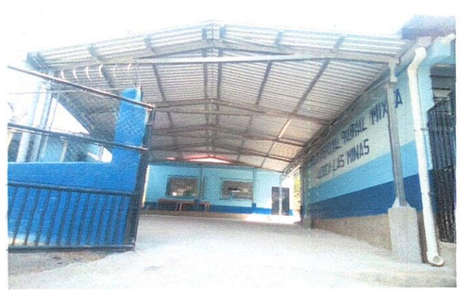
Foto 2: Mejoramiento de losa de patio.
